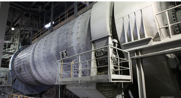
Molino de cemento. Fábrica Alcalá de Guadaíra, en Sevilla (España).
