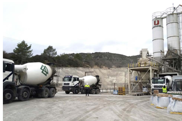
Planta de Hormigón de Vallcarca (Barcelona).
