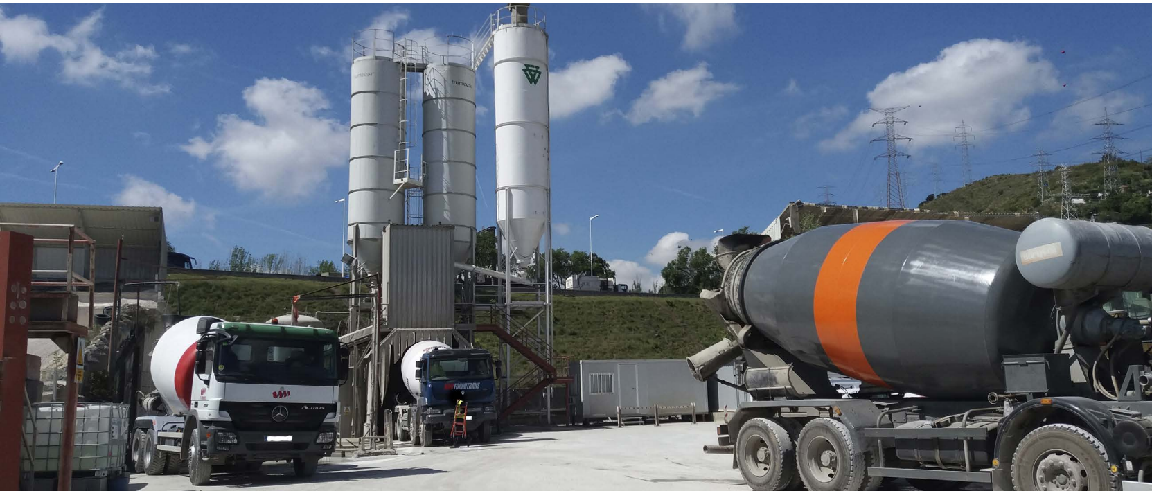
Planta de Hormigón de Trinitat (Barcelona).
